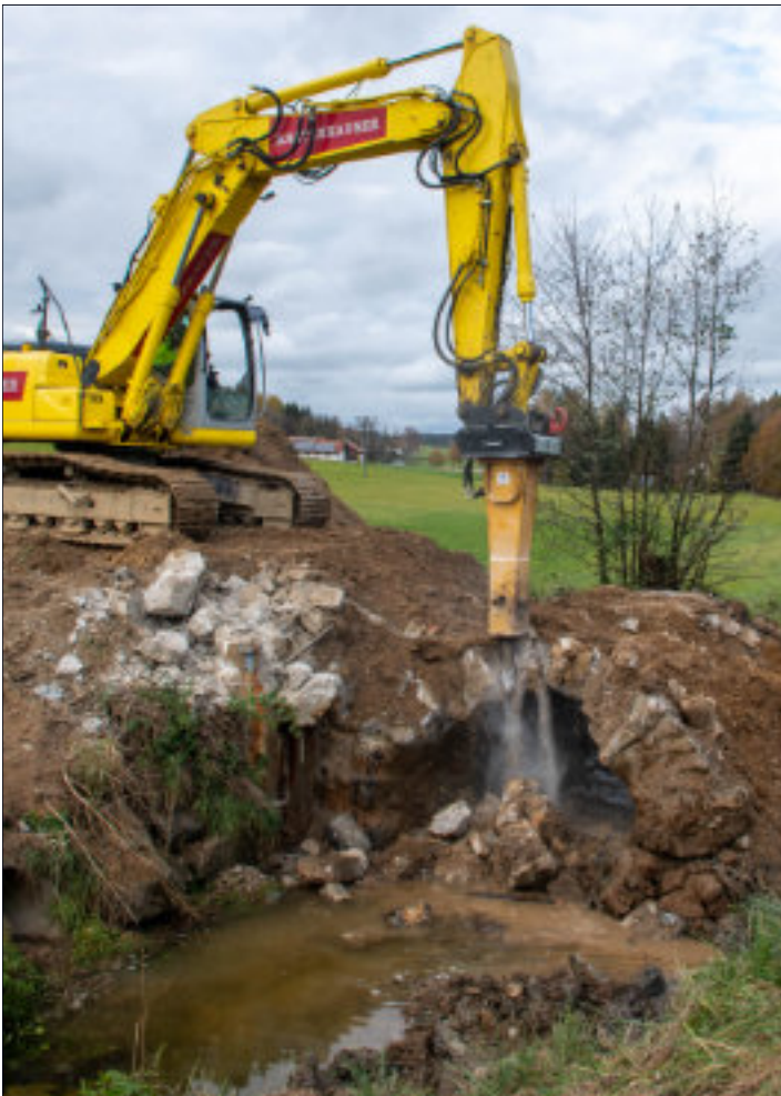
Abriss der alten Brücke mit schwerem Gerät
