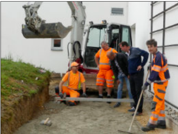
Pflasterarbeiten östlich der Turnhalle
