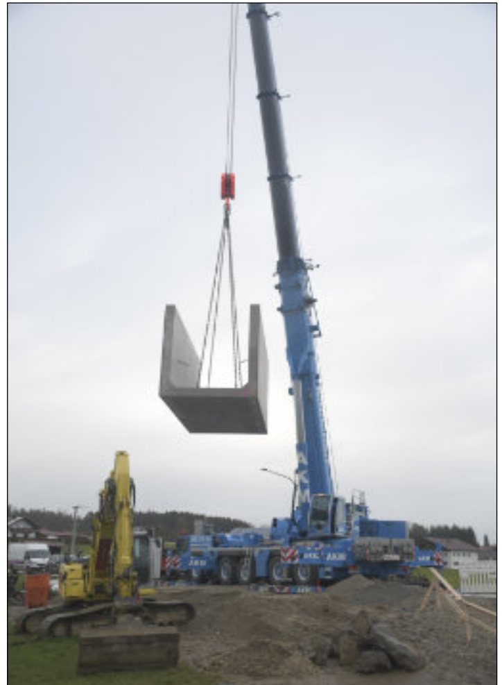
Einheben des neuen Brückendurchlasses
